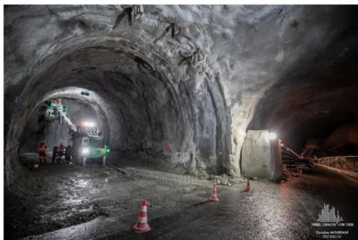
Galerie de connexion à la chambre de pied de puits
