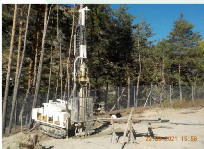
Réalisation de sondages site des Tierces
