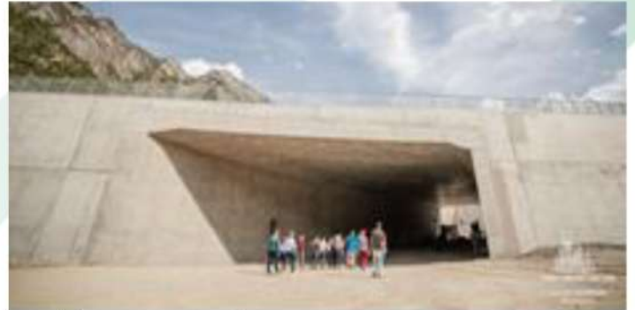
Tranchée couverte Saint Julien-Montdenis
