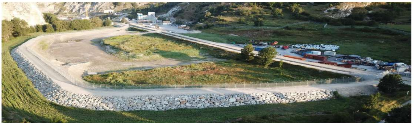
Chemin piéton aménagé et enrochement Site du Moulin
